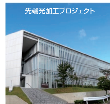
図9 京都大学大学院工学研究所イノベーションプラザ棟内(桂地区)
