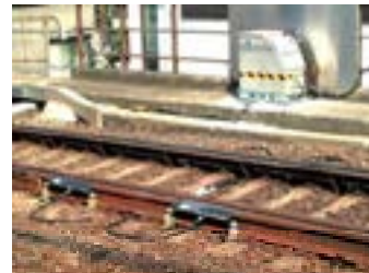
写真3 塗布装置(地上塗布タイプ)
