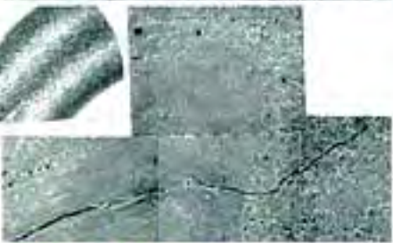
【写真6】コイルばねのばね座とのフレットング疲労損傷状況
