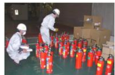
消火器の点検
