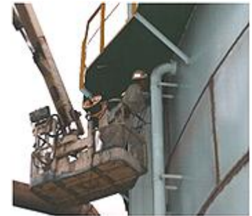
タンク外壁溶接部の超音波探傷試験
