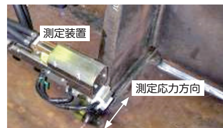
図3 橋桁仕口部の廻し溶接部での測定事例
