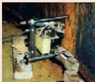
写真2 タンク内部の応力測定状況
