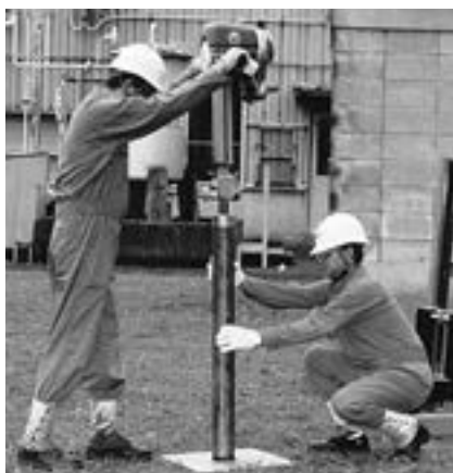
●機械簡易ボーリング(SCSC方式)
