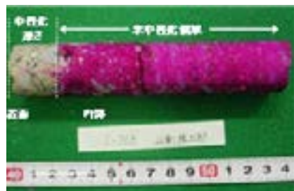
図2 コアを用いた中性化深さ測定
