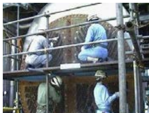
図2 熱交換器用伝熱管の内挿ET
