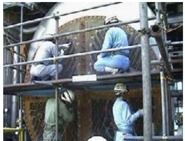
図2 熱交換器用チューブの内挿ET
