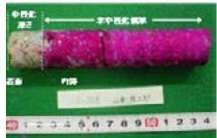
図2 コアを用いた中性化深さ測定
