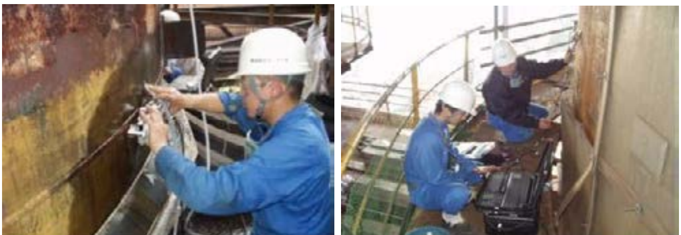
図2 TOFD法による熱風炉鉄皮SCC亀裂の調査
