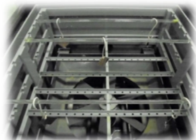
装置槽内写真
