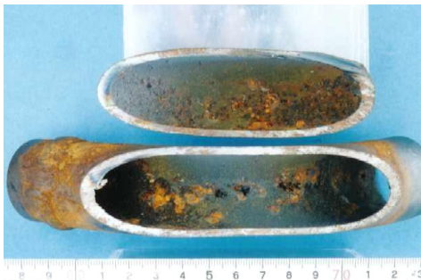
図6.供試管破孔部の内面外観
