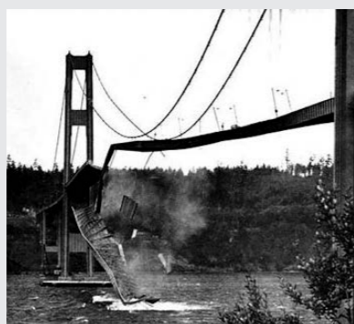
1940年11月7日 ワシントン州タコマ橋の落下事故
